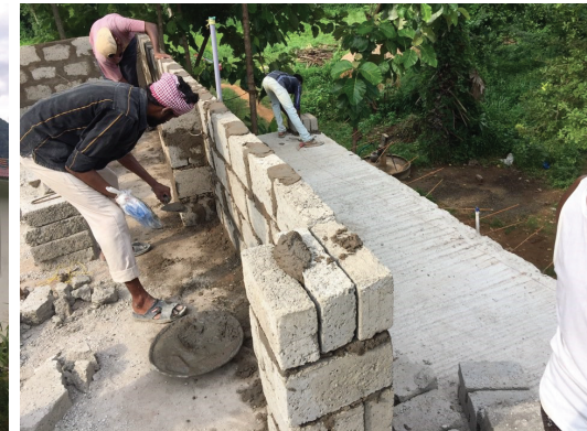
다차푸람 성전 벽돌 쌓기 공사 중
